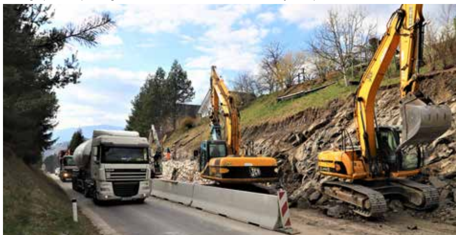
Ob cesti v Lokovici poteka izgradnja obsežne skalnate podporne škarpe na pobočju nad regionalno cesto Velenje–Lokovica–Mozirje.
