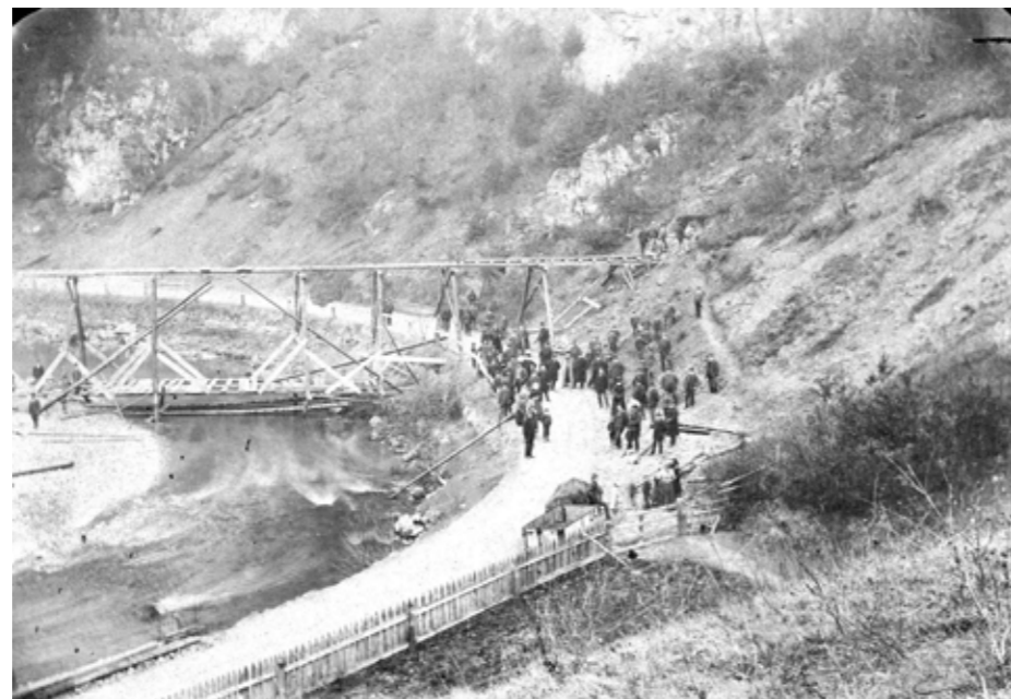
Gradnja železniškega tunela Skorno 1890 66
