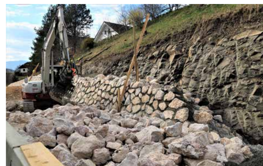
Nova skalna podporni stena bo ščitila stanovanjske hiše vrh hriba nad cestiščem.
