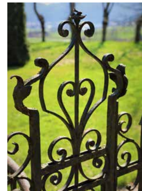
Detajl kovane železne ograje, ki kljubuje rji in času.
