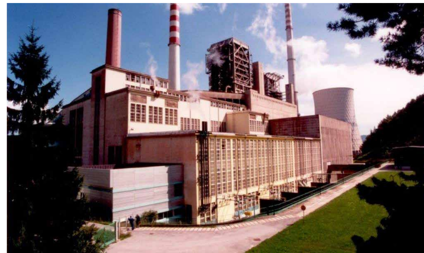
Pogled na elektrarno z JZ strani
