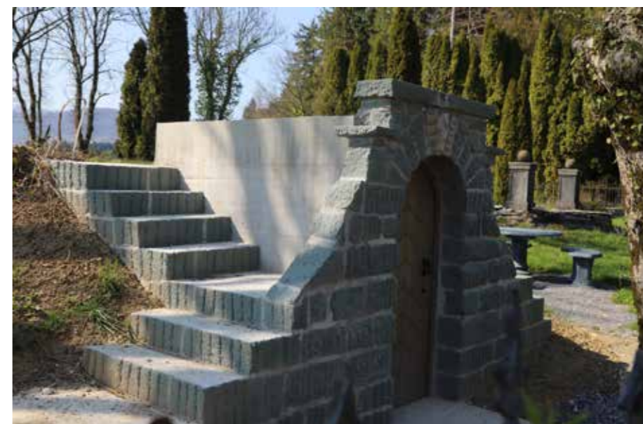
Na srečo je precej objektov v dobrem gradbenem stanju.
