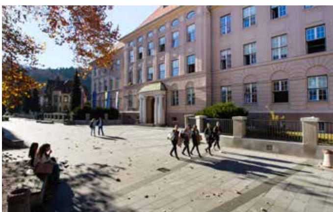
Stavba jesensko pročelje
