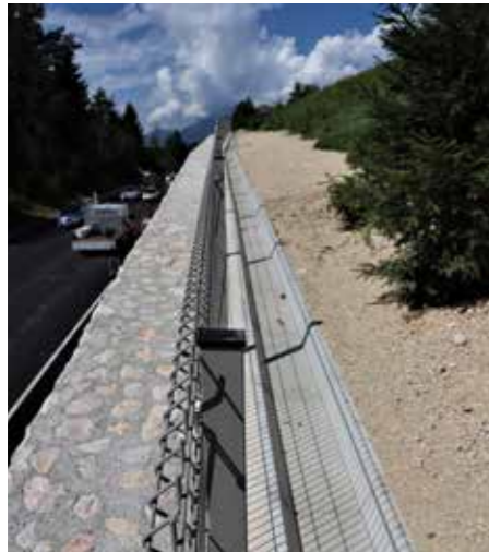
Nad cesto v smeri iz Velenja proti Lokovici mogoča skalna stena z odvodnjavanjem meteornih voda
