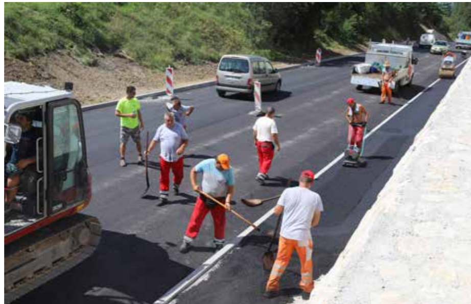
Tudi gradbeni delavci so se veselili zaključka del na prometni regionalni cesti v Lokovici.
