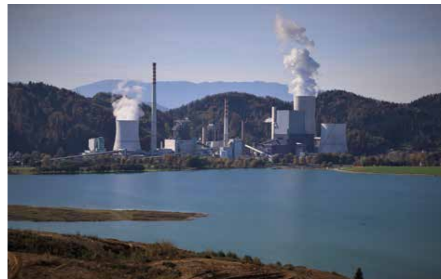
TEŠ agregat 6 odvaja paro in dimne emisije višje in manj jih je primerljivo s staro tehnologijo. Foto Jože Miklavc
