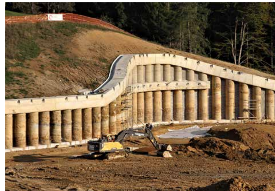
Oporne stebrne škarpe podpirajo stanovanjske objekte v Škalah.
