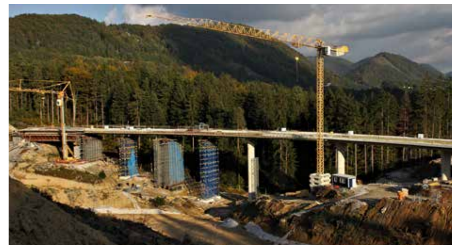
V Gaberkah so gradbena dela priključnega vozlišča v izvršilni fazi.
