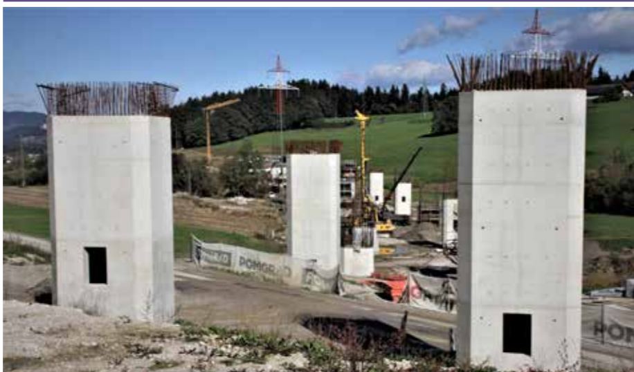
Nosilni stebri viadukta Janina in priključek Podgorje november 22 Foto Jože Miklavc
