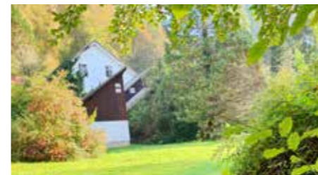
Stavba starega bazena (z dvokapnico) s prizidki in odtok, speljan v strugo potoka Toplica. Foto: Š. Poles, oktober 2022.
