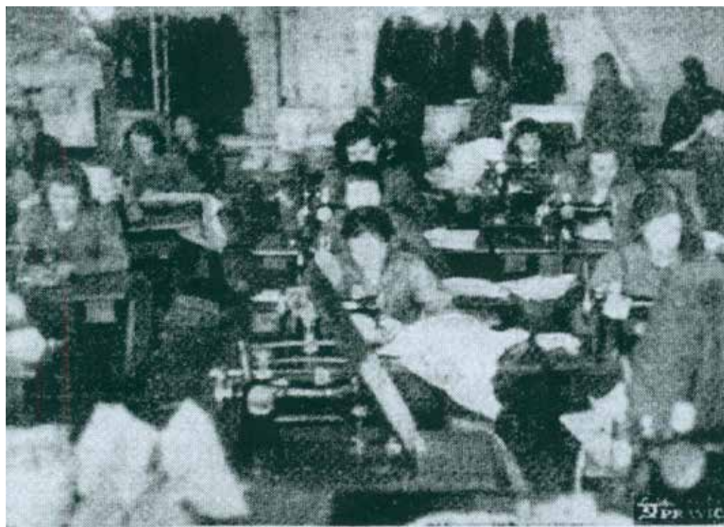
Pogled v delavnico »Tovarne otroške konfekcije«
