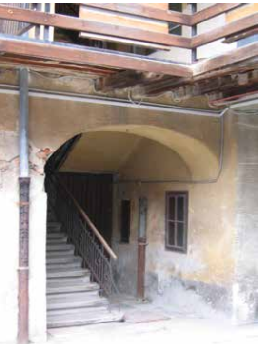
Del notranjega dvorišča s stopniščem na gank. Podhod pri hiši št. 8.
